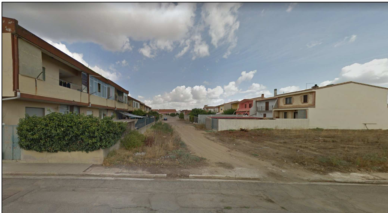
Figura 11 Foto area attesa fronte schiere Via Cagliari
