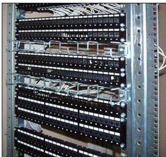
Per costruire un Sistema Strutturato di Connessione (SSC) i pannelli di connessione dovranno essere montati su armadi rack. I cavi verranno montati con lo scopo di fornire un'alta qualità di commutazione. Per ogni linea è necessaria una porta sul pannello di connessione. Un pannello di connessione rappresenta un insieme di prese il cui numero corrisponde al numero di prese ai posti lavoro. Per esempio un blocco di 24 prese corrisponde ad un pannello di connessione da 24 porte.
